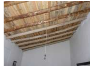
Cubierta vista desde interior
