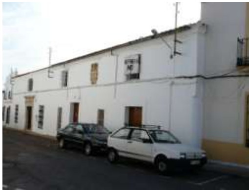
Sucesión de casas originales en calle Zafra
