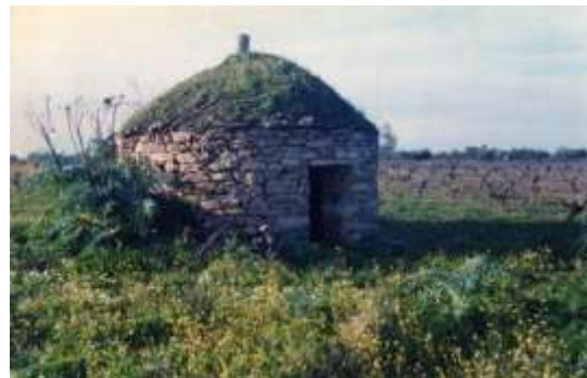
Chozo en zona de Pozo Medina
