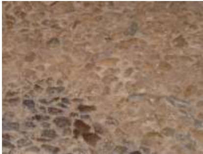
Solado de original de canto rodado
