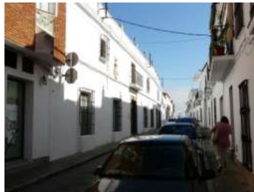
Casa solariega en C/ Teniente Blanco Marín. Posee 7 ventanas en planta baja
