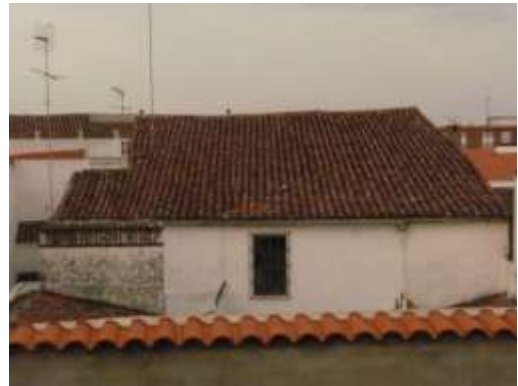
Tejado de teja árabe, fijense en la chimenea
