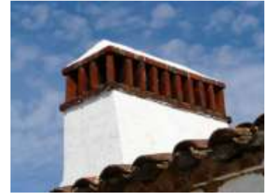
Chimenea vista desde el exterior
