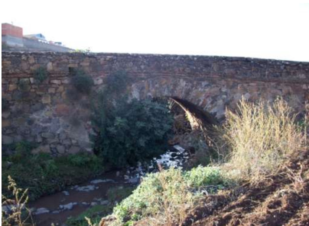
FIGURA 3: “Puente Viejo” o “Puente Grande”, sobre el Arroyo Robledillo; en la salida del Camino de Villafranca (dirección al Cementerio), al Norte de Los Santos de Maimona.
