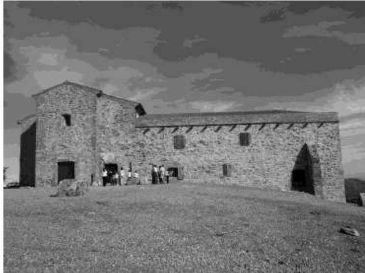
Fachada occidental del monasterio de Tudía en la actualidad. Aquí se puede apreciar la entrada a la iglesia, a la izquierda, y junto a ella la correspondiente a la entrada de la claustra del convento.
